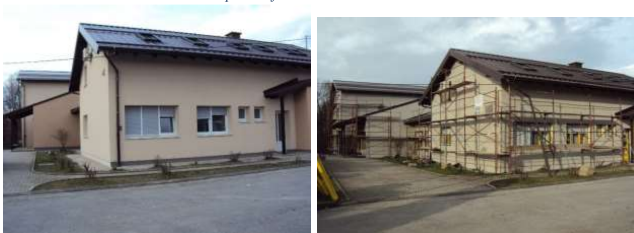
Novo krovšte i toplinska fasada OŠ Skakavac
