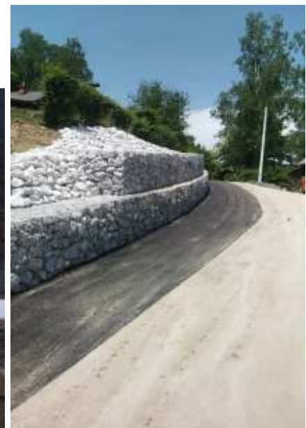
Sanacija klizišta Priselci
