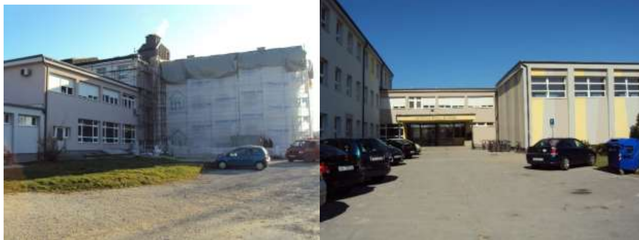
Toplinska fasada i krovšte OŠ Švarča
