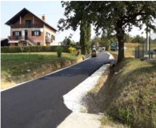
Asfaltiranje ceste Mahično
