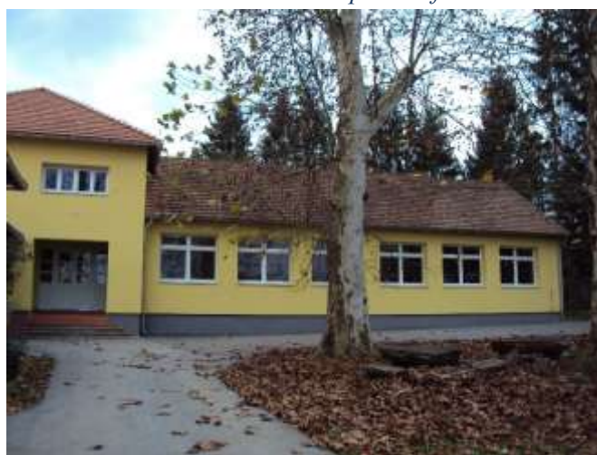
Toplinska fasada izdvojenog objekta PŠ Tušilović
