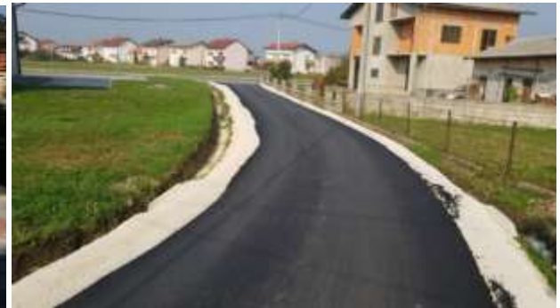
Asfaltiranje Sisačke ulice
