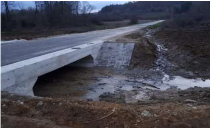
Sanacija mosta Gornji Sjeničak
