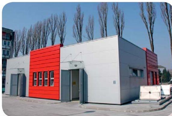
Crpna stanica Gaza
