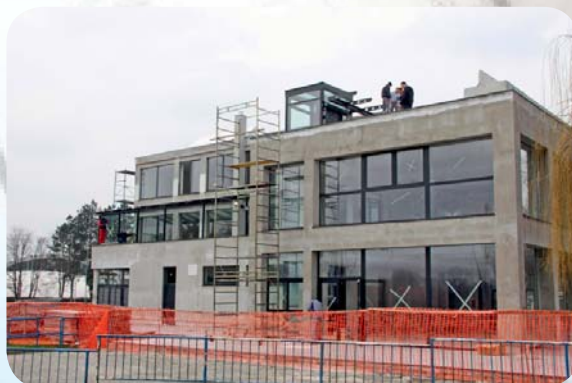
Obnova i rekonstrukcija hotela Korana -1. faza
