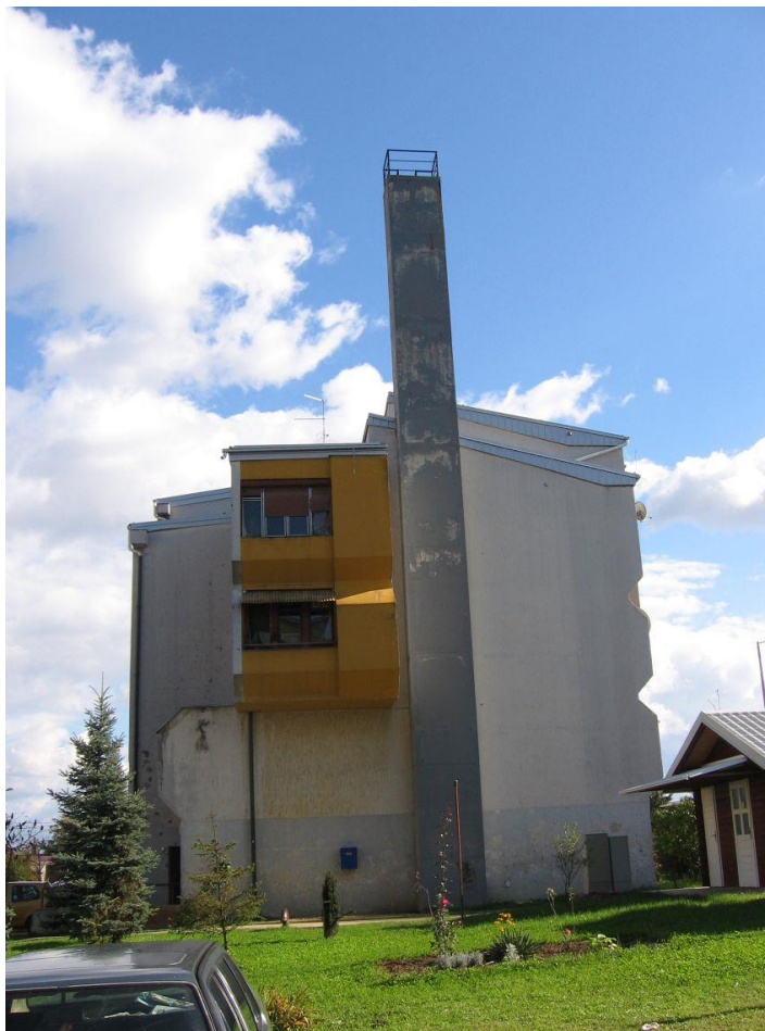
Sl. 2-4: Blok kotlovnica Švarča u Karlovcu
