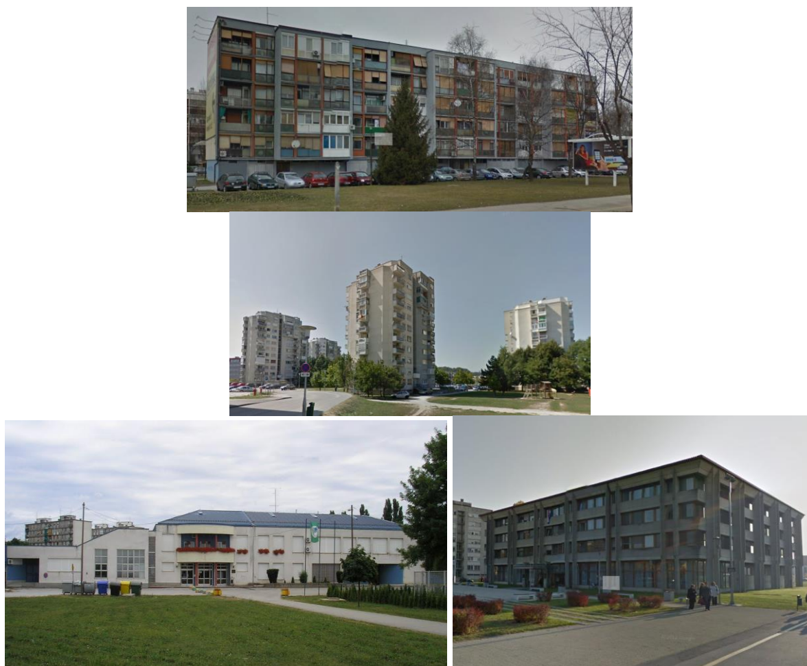
Sl. 6-1: Stambena zgrada 5 katova (gore lijevo), stambena zgrada 10 katova (gore desno), zgrada Osnovne škole Grabrik (dolje lijevo), zgrada Općinskog suda (dolje desno)
