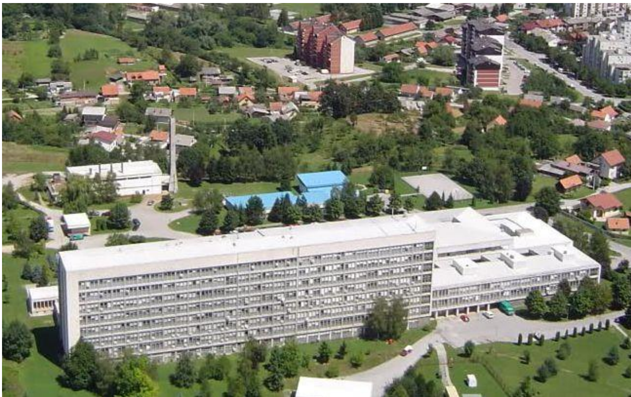
Sl. 2-6: Opća bolnica Karlovac sa vlastitom kotlovnicom
