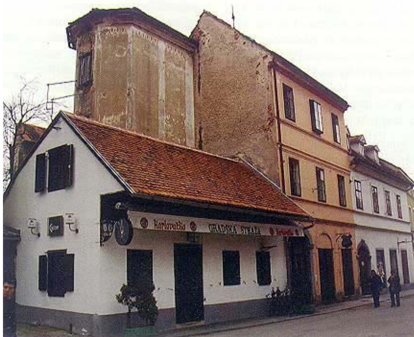
Stražarnica pred Rakovačkim vratima, danas početak Radićeve ulice
