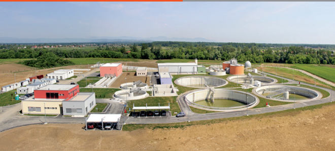
Gornje Mekuše — uređaj za pročišćavanje otpadnih voda grada Karlovca i Duga Rese
